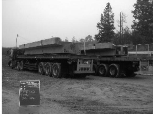
写真一 1 PCaセグメント工法（現場搬入時）
