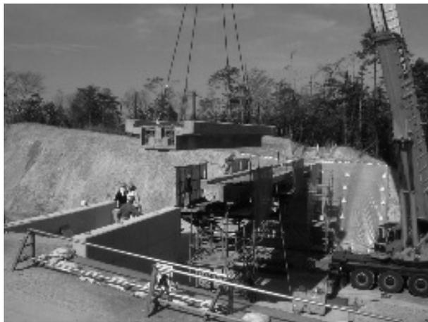
写真一 2 PCaセグメント工法（据え付け時）
