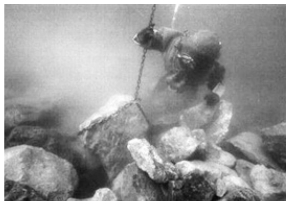
写真—1 潜水士によるマウンド築造
