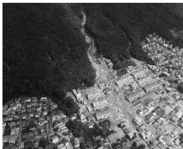
写真—5 広島県広島市安佐南区八木地区で発生した土石流災害
