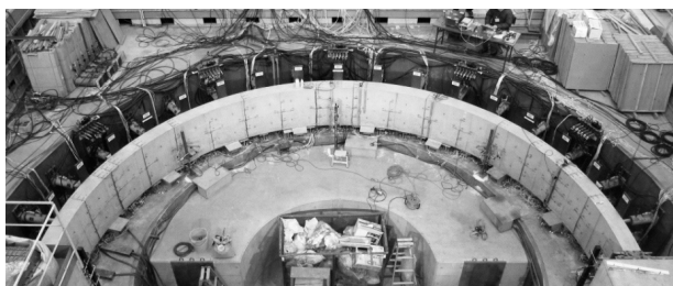
写真—4 トンネル覆工の载荷状況
