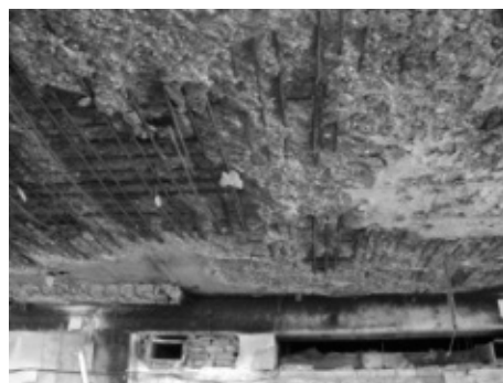
写真一 地震火災被害建物の一例と、火災後の構造体の被害例
