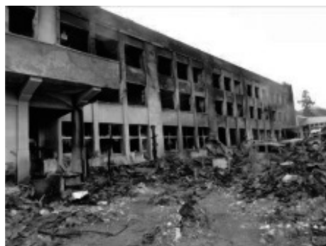
写真一 地震火災被害建物の一例と、火災後の構造体の被害例
