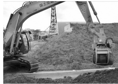
写真—5 当事務所が所有するグラップルでの大型土のう掴み上げの様子
