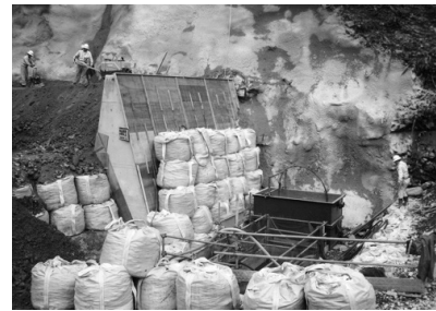
写真—6 大型土のう使用状況
