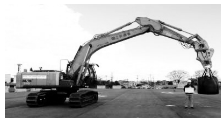
写真—11 吊荷姿勢の確認状況 バックホウ最大作業半径7.2mで吊上げ
