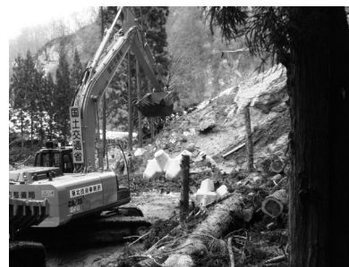
写真—1 土砂災害現場での玉掛け・玉外しの様子
