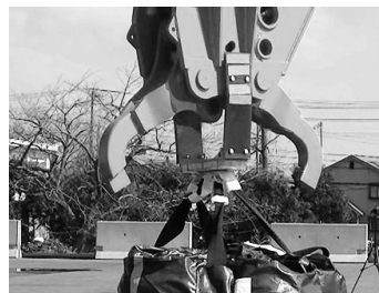
写真—10 試作アタッチメントによる玉掛け状況 （当事務所構内にて）
