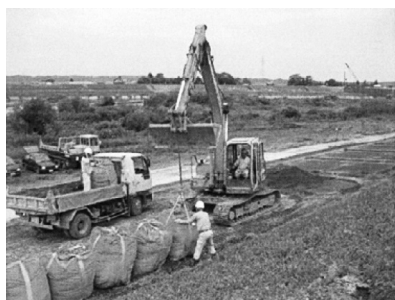
写真一2 一般的な大型土のう設置の様子
