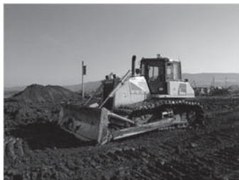
基盤整地 施工状況
