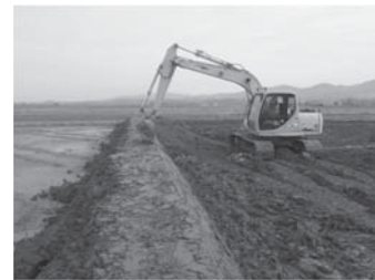
畦畔築立 施工状況
