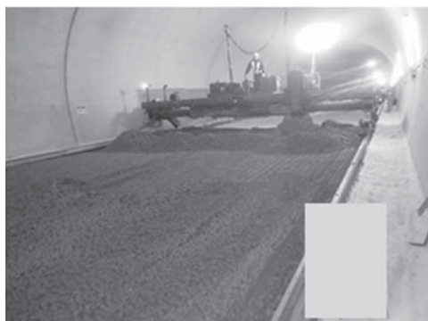
写真11 コンクリートスプレッダによる舗設状況
