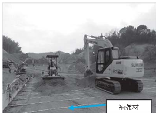
写真—2 敷均し状況
