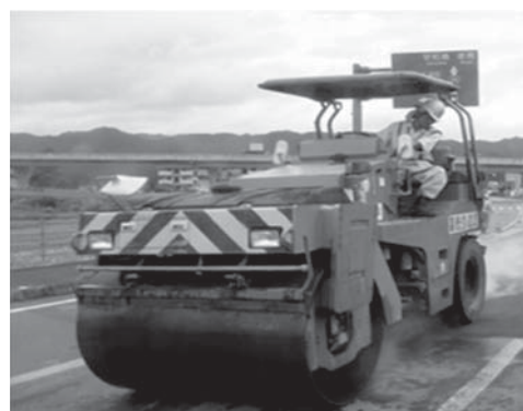
写真—5 舗装版転圧状況
