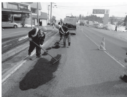
写真—6 合材敷均し状況
