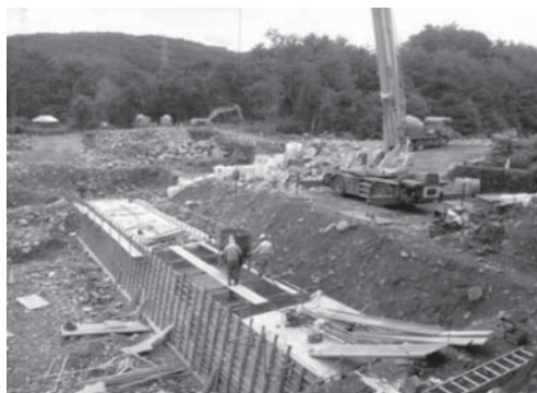
写真10 コンクリート打設状況
