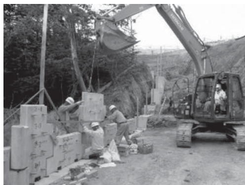
写真—8 壁面材組立状況
