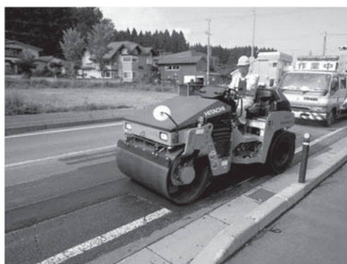
写真—7 締固め施工状況
