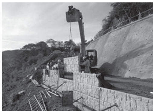
写真—1 壁面材組立状況
