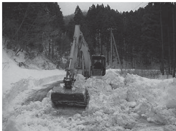
写真一5 県東部の除雪作業：静岡県交通基盤部提供
