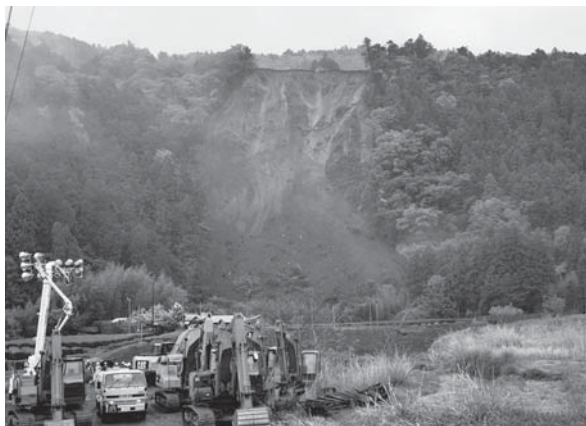
写真一 天竜区春野の地滑り：建通新聞社提供
