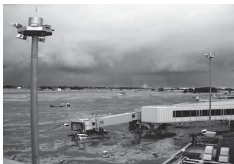
写真一 仙台空港エプロン等の被災状況
