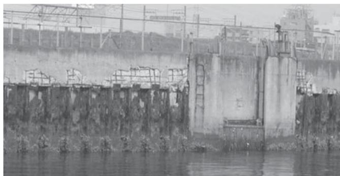
写真一 3 鋼矢板の腐食・コンクリートの劣化
