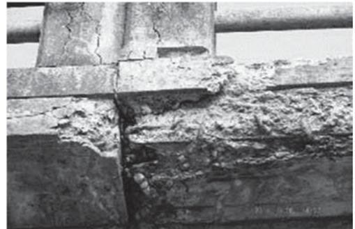
写真一 5 損傷：コンクリートのはく離
