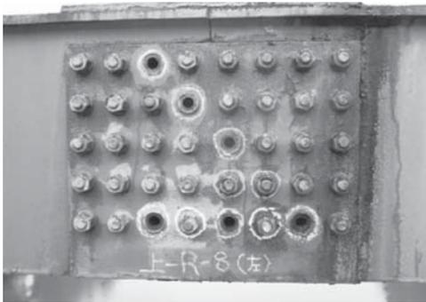
写真一 3 損傷：ボルトの脱落
