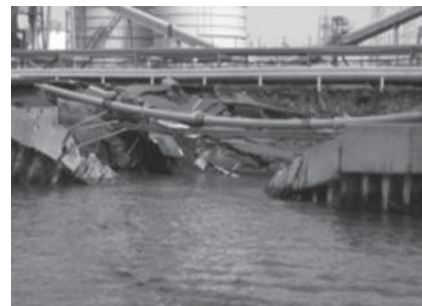
写真一 東日本大震災における私有護岸の被災
