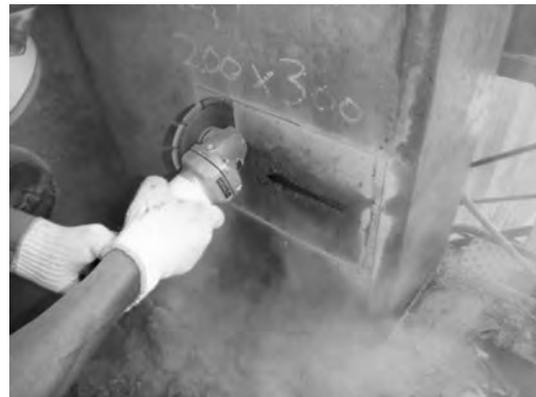
写真一9 断面修復（左官工法）カッター作業
