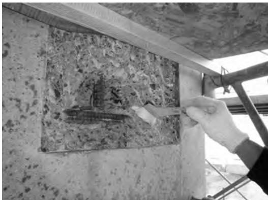
写真一14 断面修復（左官工法）プライマー作業
