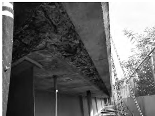
写真一11 断面修復（左官工法）はつり作業後
