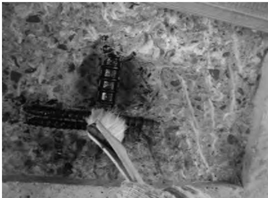
写真一13 断面修復（左官工法）鉄筋防錆処理作業
