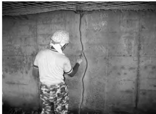
写真一６ ひび割れ充てんプライマー塗布作業
