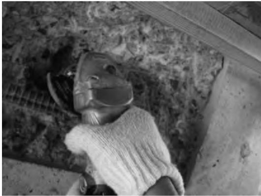
写真一12 断面修復（左官工法）鉄筋ケレン作業
