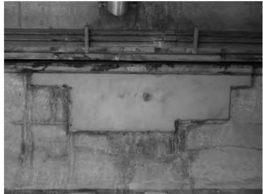
写真一16 断面修復（左官工法）補修完了状況
