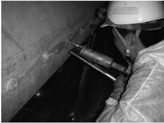
写真一４ 低圧注入器具への注入
