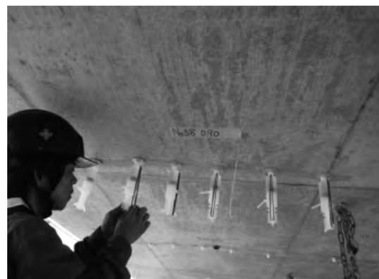
写真一2 低圧注入器具設置状況（ゴム圧）
