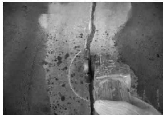
写真一５ ひび割れ面のカット状況
