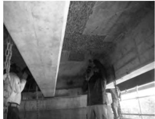
写真一10 断面修復（左官工法）はつり作業
