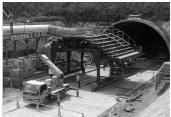
写真-3 防水作業台車組立状況
