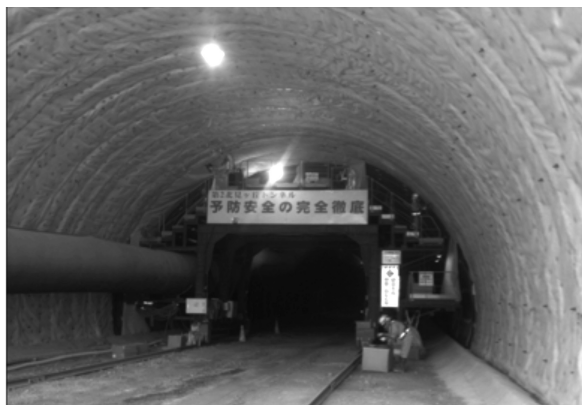
写真一 4 防水作業台車
