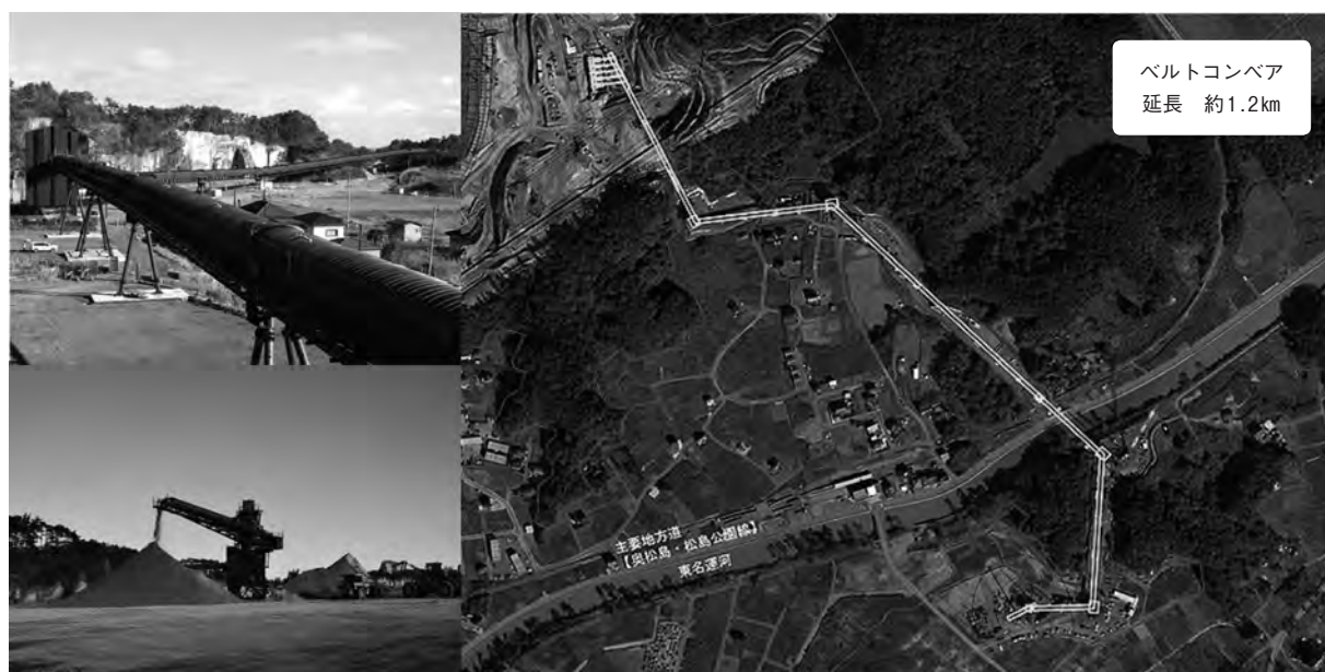
写真一 1 ベルトコンベアによる土砂搬出状況
