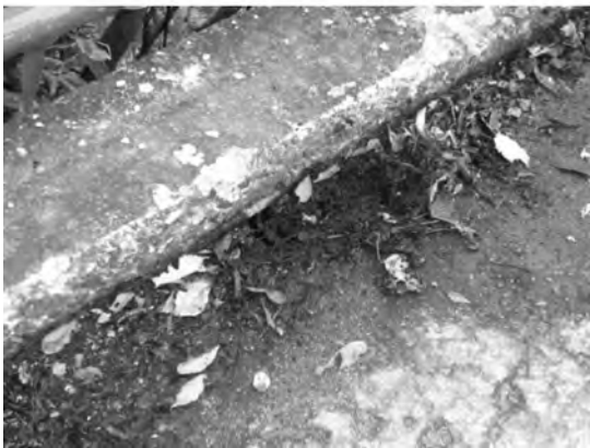
写真一 2 水の作用による劣化事例とその原因
