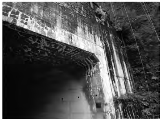
写真一1 地域のインフラの劣化事例
