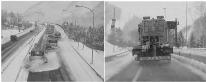
写真一 除雪および凍結防止剤散布状況
