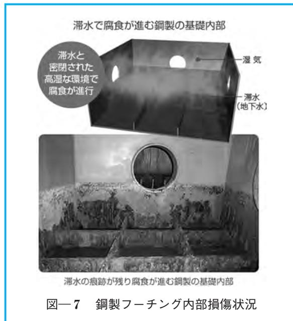
図-7 鋼製フーチング内部損傷状況
