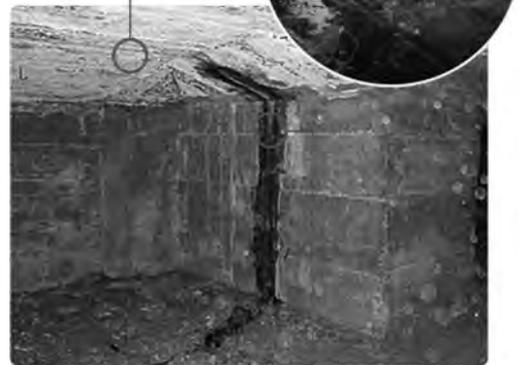
大きくひび割れが入り、浸水で腐食した鉄筋の錆汁が中から流れ出ています。
