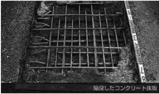
写真-3 床版陥没と腐食した補強鋼板
