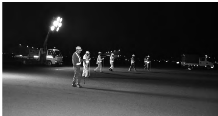
写真—1 巡回点検の様子
