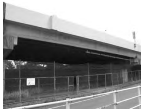
写真—1 カメラ活用の橋梁試行現場
