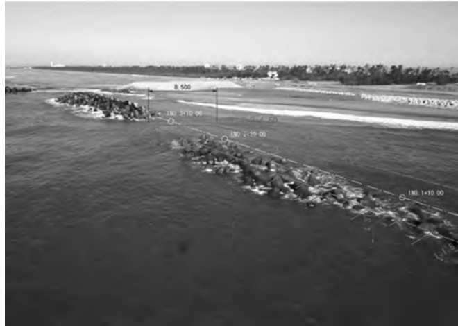
写真一七 消波堤・被災前形状の線形表示例
