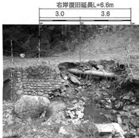
写真一 4 全景写真（右岸）
