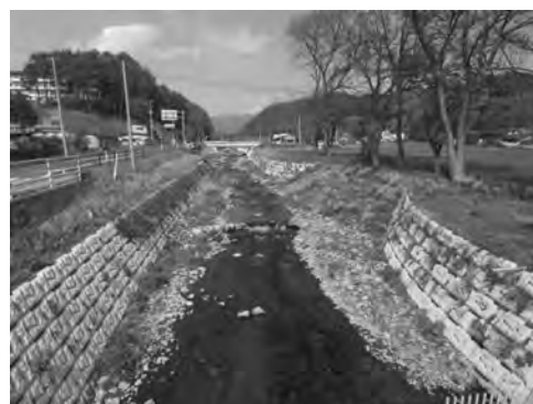
写真一 1 川幅の変化と河岸・護岸のデザイン川幅が広がっているところは緩勾配
