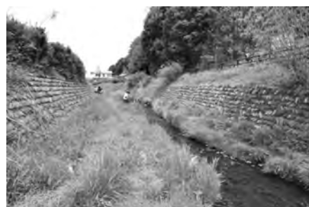
写真一 2 水際部を再生した例
