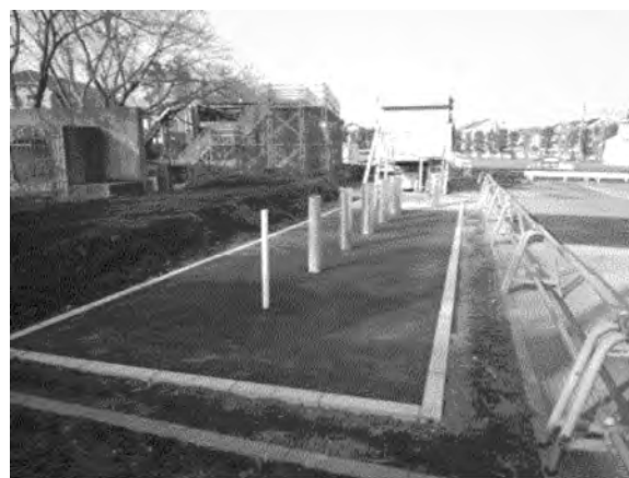
写真-1 関技構内の模擬試験柱
