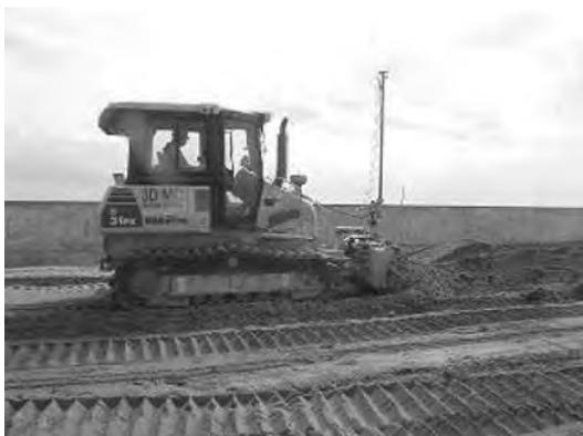
写真一8 MC技術（ブルドーザ）施工状況
