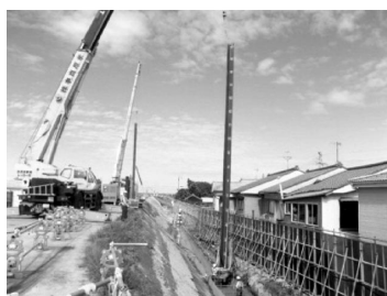
写真-1 住宅地での施工状況
