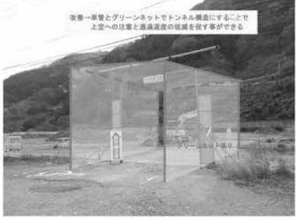
改善→単管とグリーンネットでトンネル構造にすることで上空への注意と通過速度の抑制を促す事ができる
