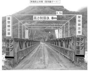
運搬時に架空線直近には誘導員を配置し、注意喚起の明示(看板、のぼり旗)を運転手の目の高さになるように設置する
