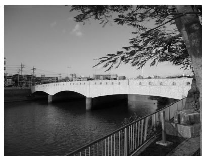
写真—4 現在の真玉橋
