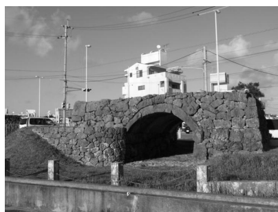
写真—3 復元された真玉橋遺構
