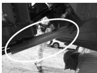
写真—6 ガスダンパー取り付け状況
