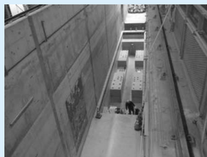
図—3 左：振動台の概要（長さ12m、幅2.5m、最大変位±20cm）右：基礎部の工事状況
