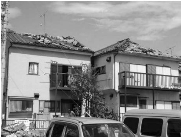
写真 3 平成25年9月2日に埼玉県越谷市で発生した竜巻による被害（屋根瓦の脱落）
