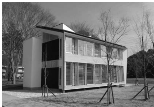
写真 2 環境実験住宅（外観）
