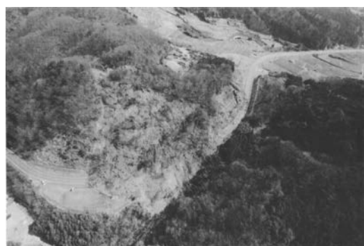
写真—2 県道の被災事例
