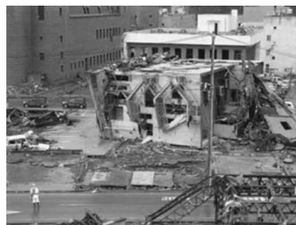
写真—4 外壁材が残存したまま転倒した建築物
