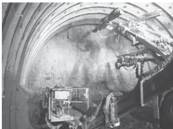
写真一2 ドリルジャンボ作業状況
