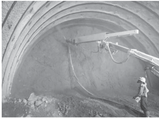
写真-4 コンクリート吹付作業状況
