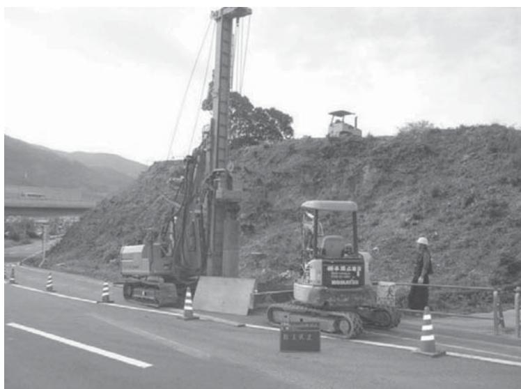
写真-1 ダウンザホールハンマ施工状況
