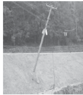
写真一3 折れた電柱
