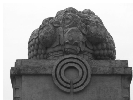
写真－4 タワーの頭頂部
