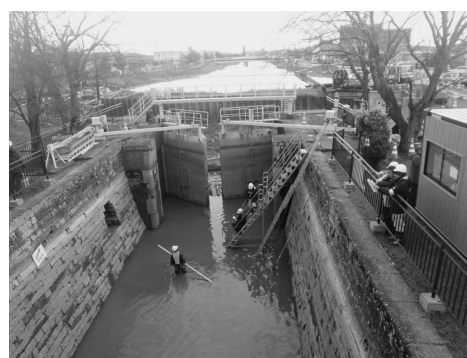
写真－3 水抜き調査の実施状況
