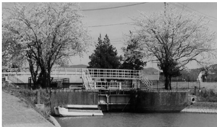
写真－1 震災前の閘門全景
