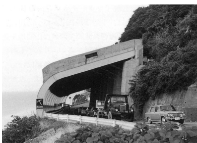
写真 5 昭和42年に完成した国道8号(第三世代)
