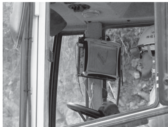
写真一五 ローラに取り付けられた転圧パターンのモニター
