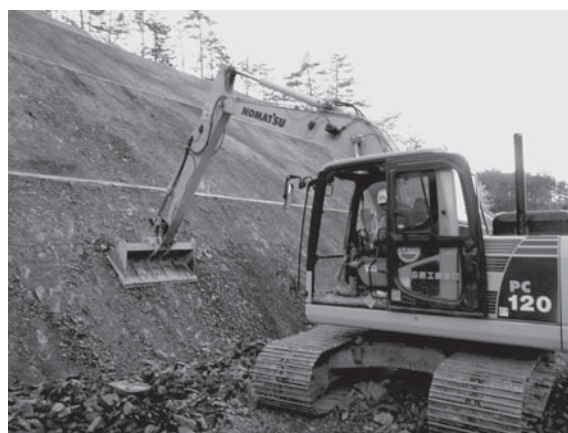
写真—7 2D-MGショベルでの法面整形作業
