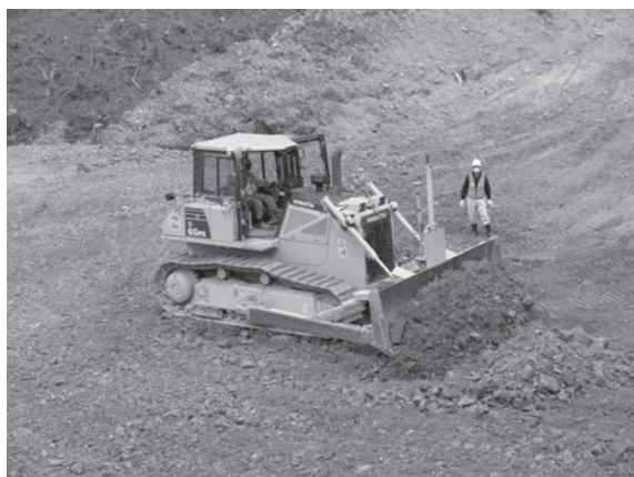
写真—3 GNSS-VRS-RTK制御稼働中の3D-MCブルドーザ
