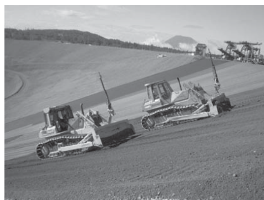
写真-1 2台のTS式3D-MCブルドーザによる施工
