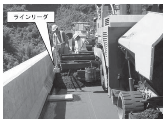
写真-6 ラインリーダーによる施工例
