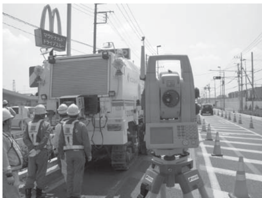
写真―4 3D-MCで作業中のクローラ式切削機
