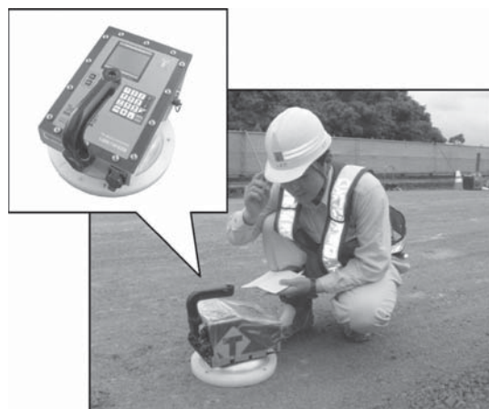
写真—8 路盤密度測定器による計測状況
