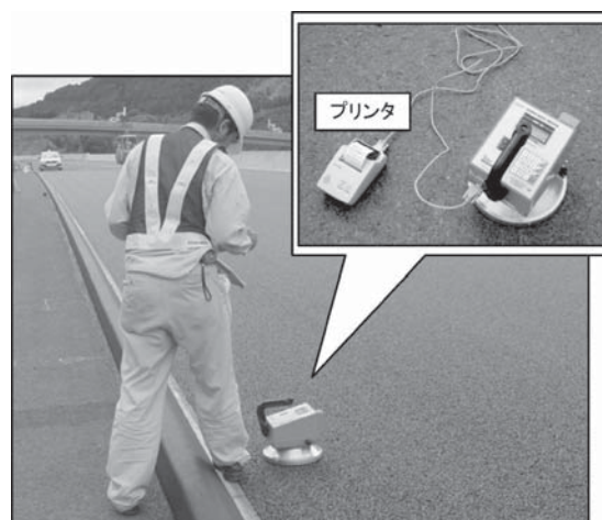
写真—7 アスファルト舗装密度測定器による計測状況
