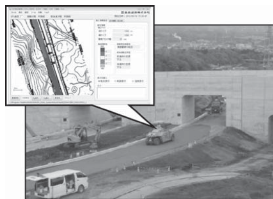
写真―5 転圧管理システムの表示例
