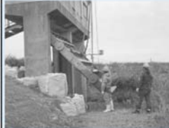
取り外し状況
