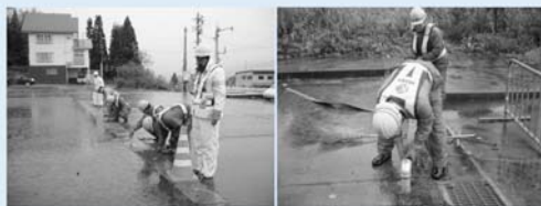
消雪パイプ点検状況
