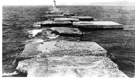
写真 3 幾度の時化で被災した防波堤
