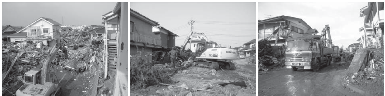
写真—6 がれき撤去作業(仙台市内)
