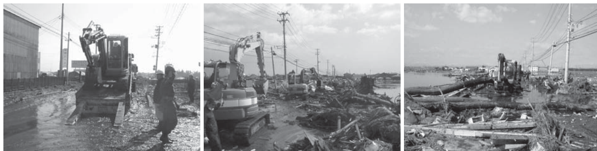
写真—4 道路啓開作業（仙台市内）
