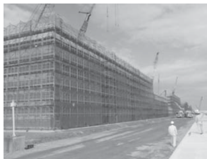
写真—8 防波堤ケーソン作成状況 (相馬港3号ふ頭背後)
