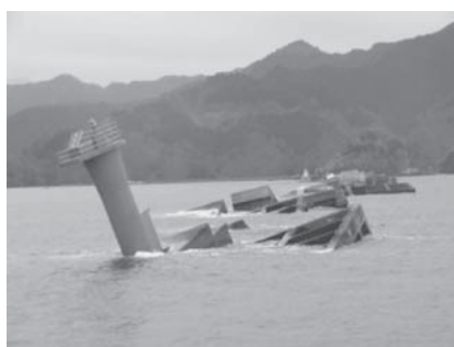
写真二 倒壊した湾口防波堤 (釜石港)
