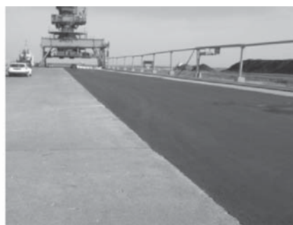
写真一5 小名浜港5号ふ頭岸壁背後の陥没（左：H23.4.19）と応急復旧状況（右：H23.4.27）
