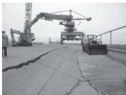
写真一5 小名浜港5号ふ頭岸壁背後の陥没（左：H23.4.19）と応急復旧状況（右：H23.4.27）
