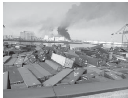
写真三 津波によるコンテナの散乱 (仙台塩釜港)
