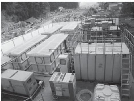
写真一 1 ユニット型膜処理システムによる処理場と別位置での応急対応状況（岩手県陸前高田市）
