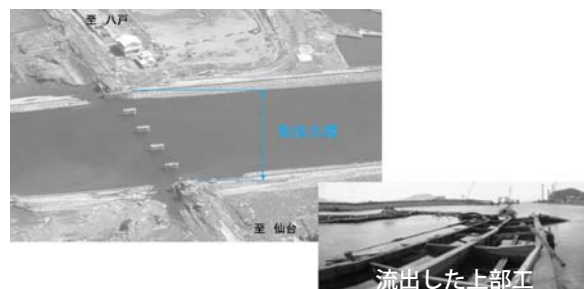
写真一 津波により上部工が流失した気仙大橋
