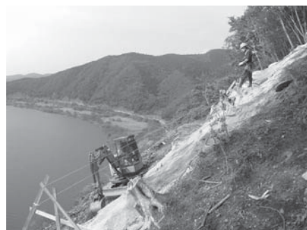
写真—3 小型無人バックホウによる切り崩し
