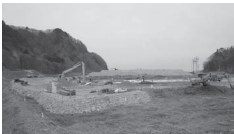
写真—10 サケふ化場造成状況(岩手県田野畑村)
