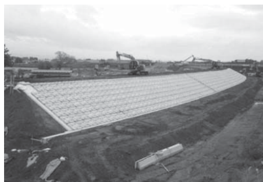
写真—9 完成状況
