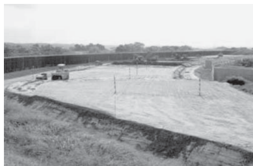
写真—8 地盤改良後の再盛土状況
