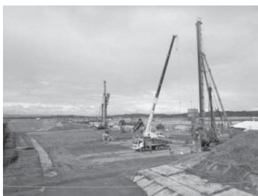
写真一11 深層改良（サンドコンパクションパイル工法）実施状況
