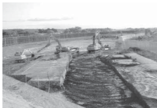
写真—7 浅層地盤改良（セメント改良）実施状況
