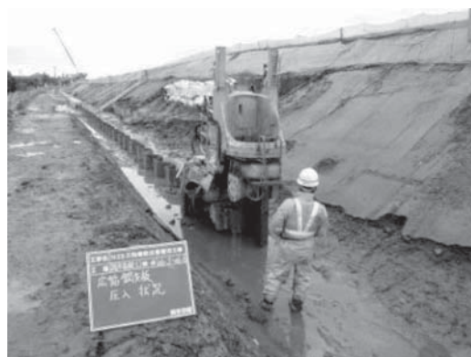
写真一14 法尻対策（鋼矢板等）施工状況
