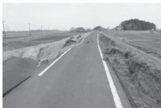
写真一15 久慈川被災状況 (茨城県那珂市本米崎地先)
