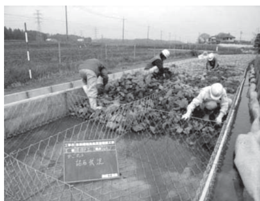
写真一16 法尻対策（ドレーン工）施工状況
