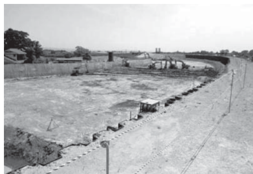
写真—6 鋼矢板二重締切施工による堤防切返し状況
