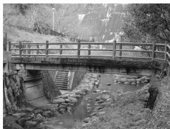
写真—6 ダム通路橋梁
