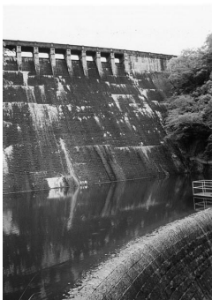
写真—5 ダム余水緩衝池
