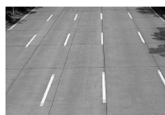
コンクリート舗装
