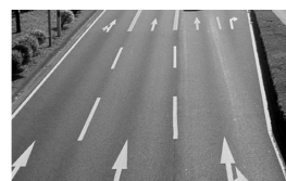
アスファルト舗装
