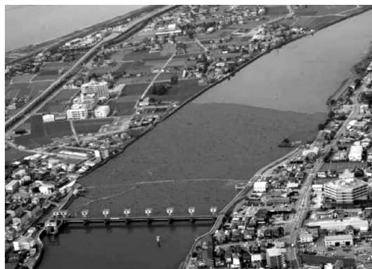
写真－1 水草の大量発生状況 (平成20年 河口堰付近)
