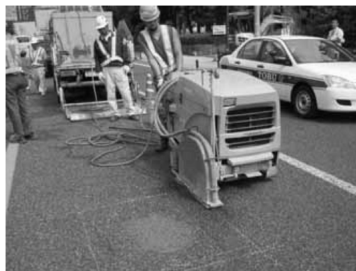
写真—1 舗装版切断作業
